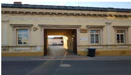
Vstup do budovy
