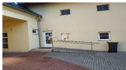
Vchod C, nájezdová plošina
